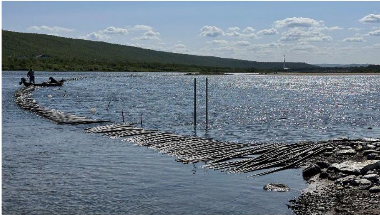
Kelluva putkiaita länsiväylässä
