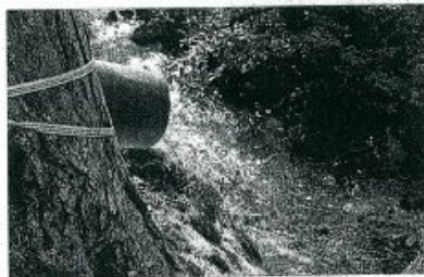
Pajupuroon valutettiin keskivälkkönä putkea pitkin karkeaa soraa taimenten kutupaikoiksi.
